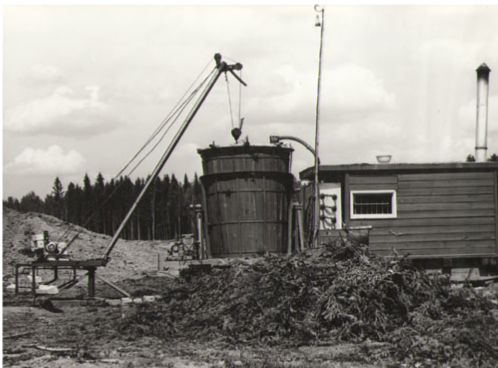
1982 год. п. Обманка 1. Пихтоваренная установка Лысьвенского гослесхоза по производству пихтового масла
