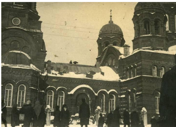
Разборка кровли храма
