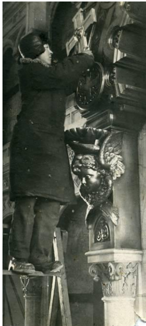
Демонтаж внутреннего убранства храма
