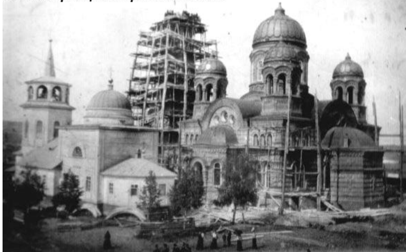
Строительство нового каменного Свято-Троицкого храма в Лысьве
